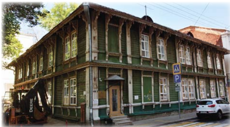
В современной Огородной слободе еще можно найти несколько симпатичных старинных домов, но в целом район убит постоянными стройками и реконструкциями
