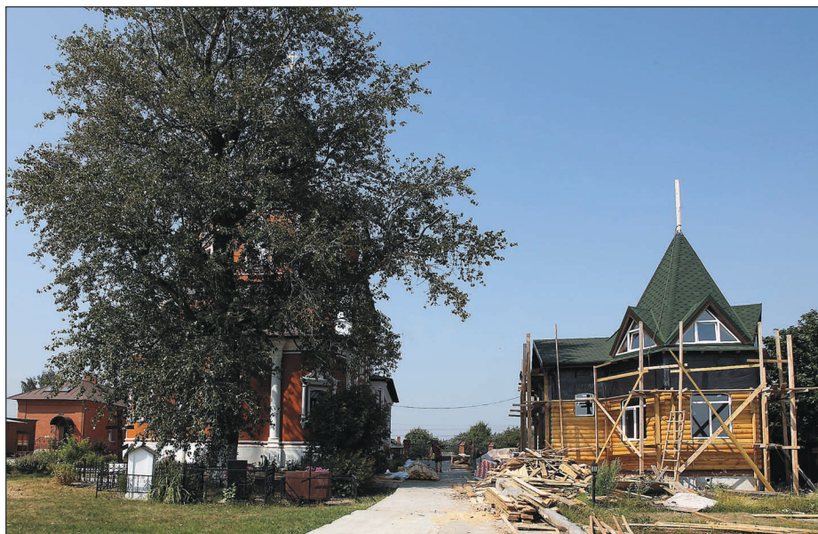
Строительство крестильни при Никольской церкви
