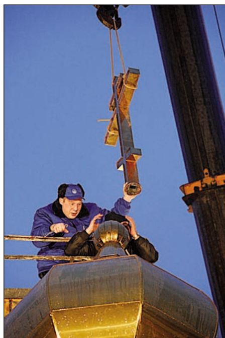
Подготовка к подъему и установка креста
